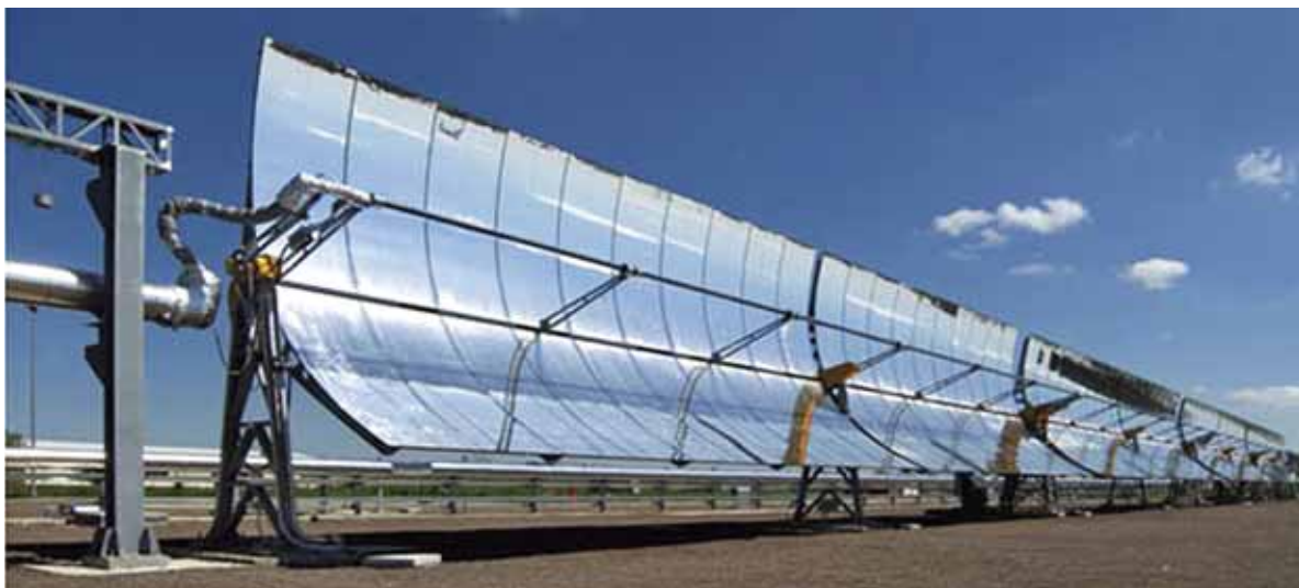
Dall'alto: > Centrale solare termodinamica a concentrazione di Priolo Gargallo (SR), realizzata all'interno dello stabilimento Enel. > Centrale a biomassa nel Comune di Santa Caterina di Valfurva (SO), all'interno del Parco Nazionale dello Stelvio
