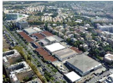
Ambito n.2 Risistemazione della Fiera di Roma - Piano di Utilizzazione delle aree della Via Cristoforo Colombo da Porta Ardeatina a Via delle Tre Fontane
