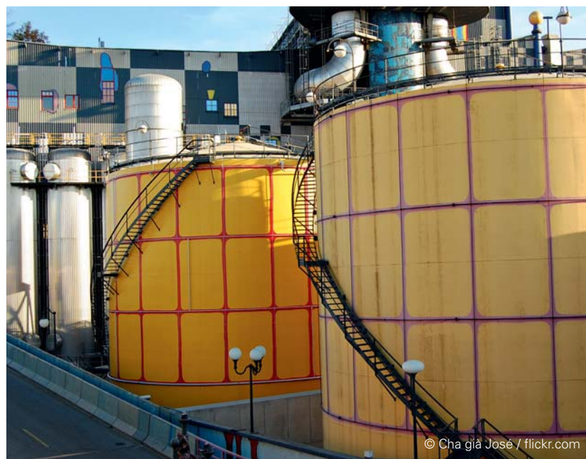
Termovalorizzatore di Spittelau |
