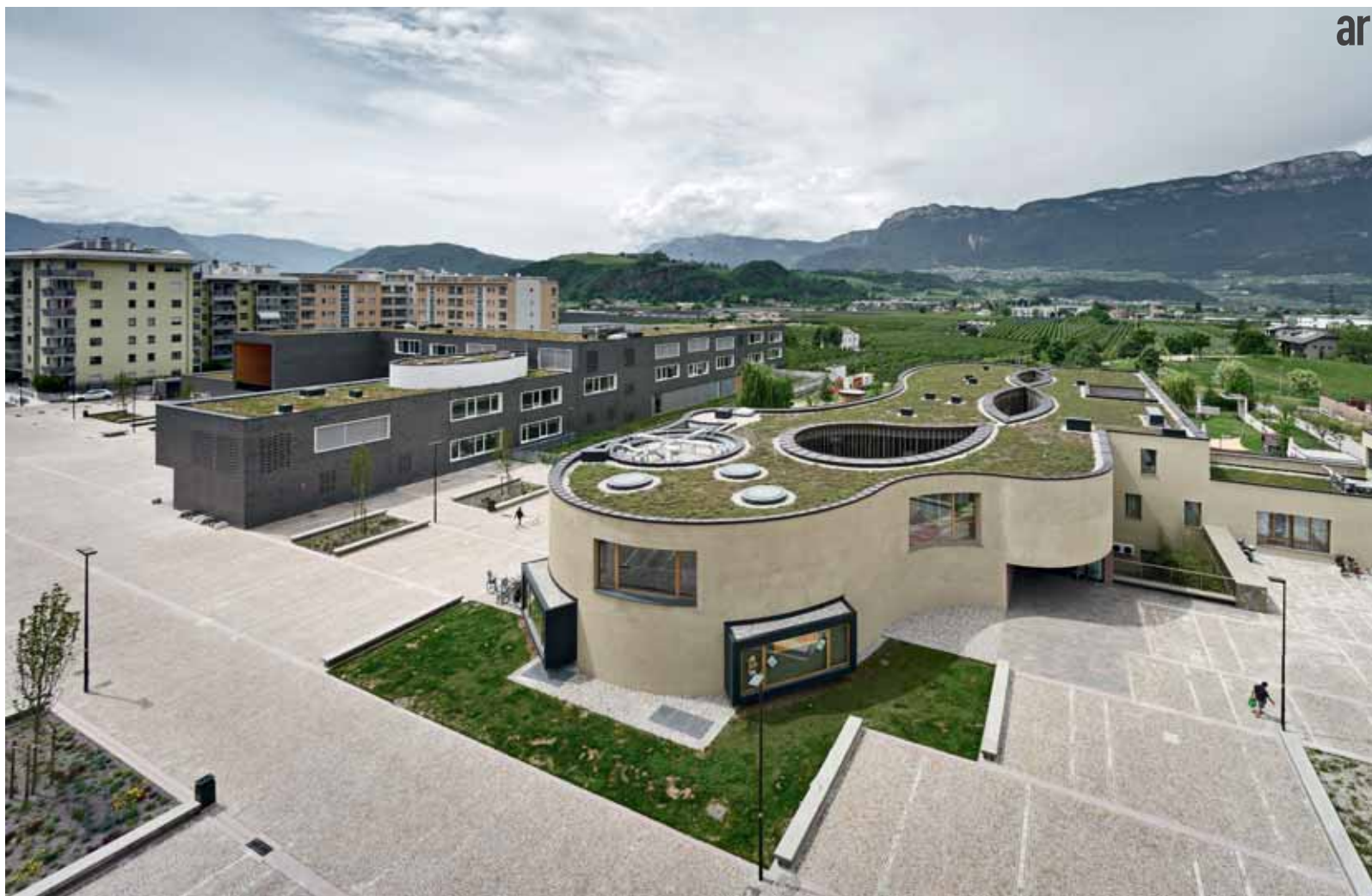
A fianco: Ristrutturazione e ampliamento di una scuola elementare a Ora (Bolzano) In alto: Complesso scolastico nel quartiere Firmian a Bolzano © Oskar Da Riz
