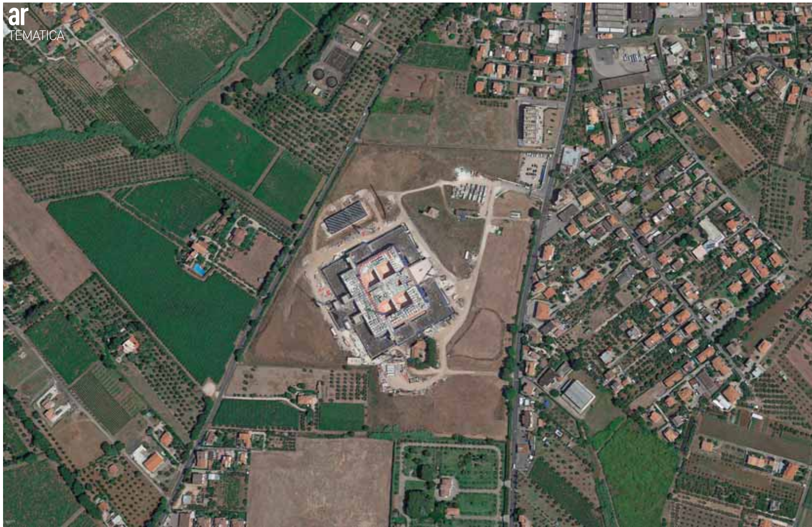
| Veduta aerea del cantiere
