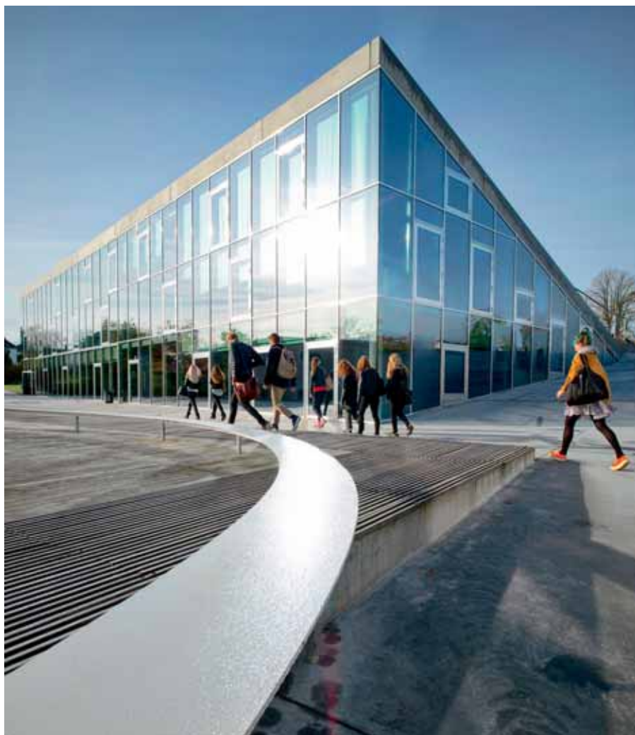
Istituto d'istruzione Gammel Hellerup, 2015, Copenaghen, BIG - Bjarke Ingels Group
