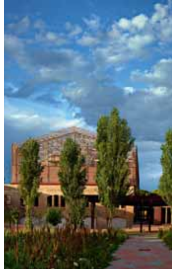
In alto: Istituto d'istruzione, 2010, Riccione, Pietro Carlo Pellegrini Architetto
