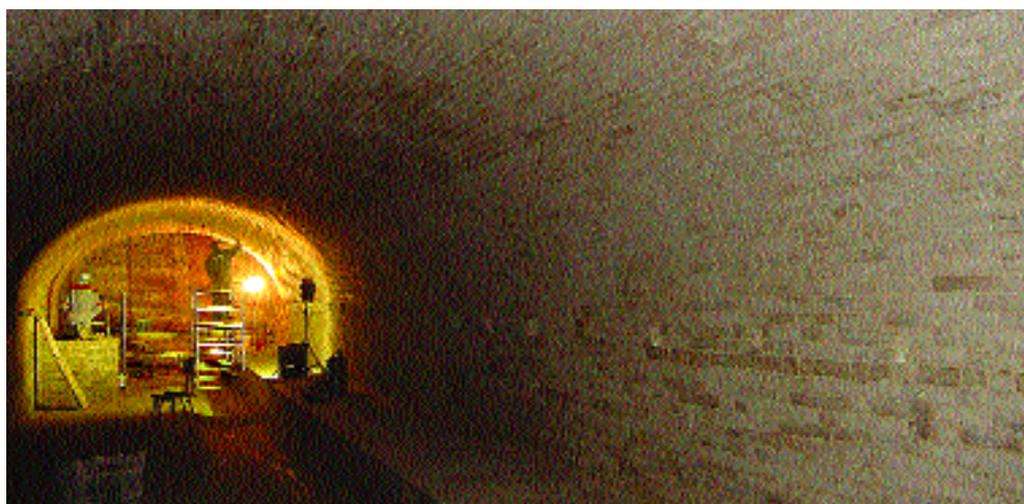
discontinue e non omogenee a causa della presenza delle fondazioni delle murature sovrastanti, in roccia nella parte superiore e in mattoni nella parte inferiore.
