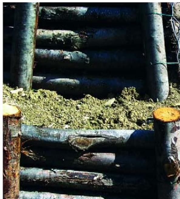
• Stabilizzazione e consolidamento di una scarpata stradale in frana mediante la costruzione di un'opera di sostegno realizzata in Terra Rinforzata rinverdibile abbinata alla tecnica della palizzata in legname con talee e/o con piantine.
