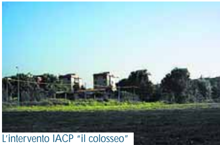
L'intervento IACP "il colosseo"
