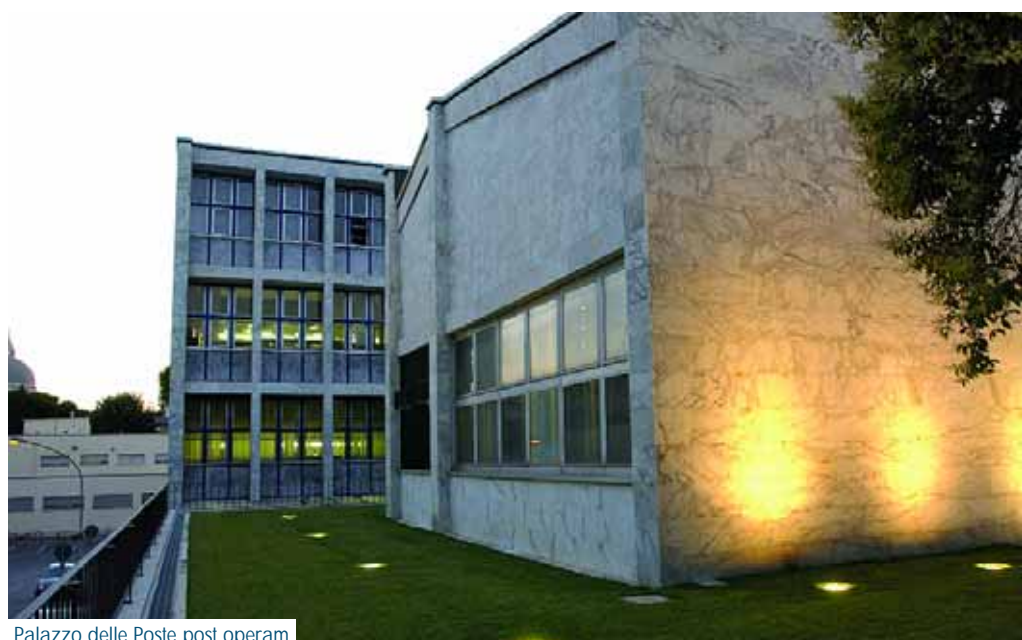
Palazzo delle Poste post operam
