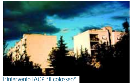
L'intervento IACP "il colosseo"
