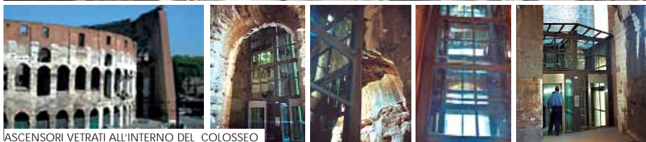
ASCENSORI VETRATI ALL'INTERNO DEL COLOSSEO
