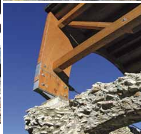
Particolari dell'appoggio della copertura sulle strutture antiche (foto A. Pergoli Campanelli, V. Fasolo)
