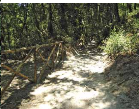
SENTIERO DELLA MOLA, DOPO L'INTERVENTO
