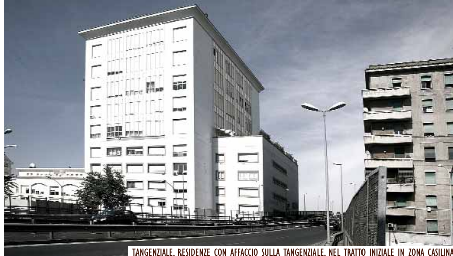
TANGENZIALE, RESIDENZE CON AFFACCIO SULLA TANGENZIALE, NEL TRATTO INIZIALE IN ZONA CASILINA
