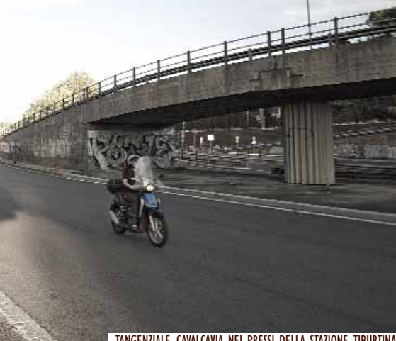
TANGENZIALE, CAVALCAVIA NEI PRESSI DELLA STAZIONE TIBURTINA
