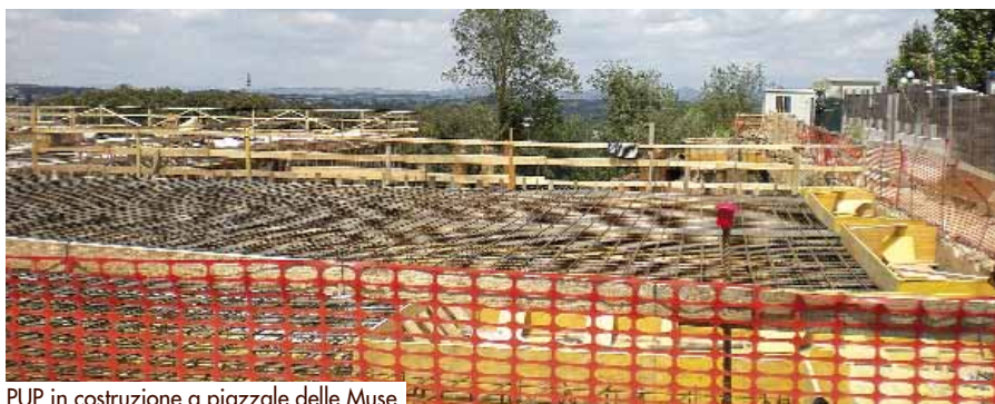
PUP in costruzione a piazzale delle Muse
