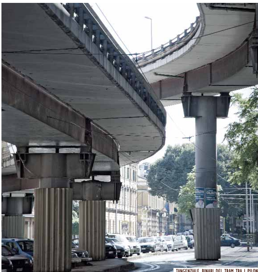
TANGENZIALE, BINARI DEL TRAM TRA I PILONI
